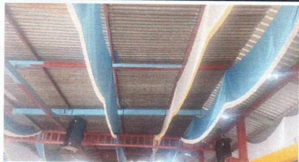
Foto No. 1 Sustitución de laminas viejas a laminas nuevas marca troquelada calibre 26.
