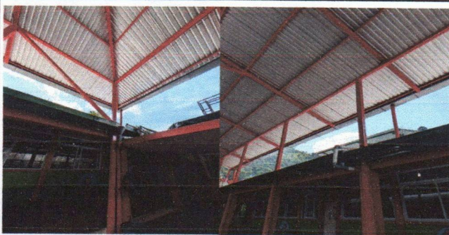
Foto 5: Sustrucción de bajadas de agua.
