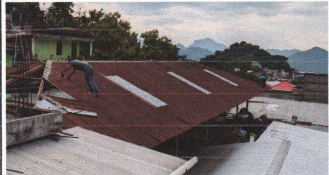
Foto 2: Sustrucion e instalación de canales.
