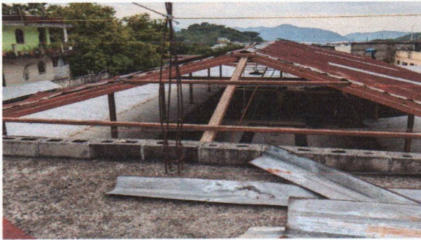
Foto 1: Sustrucción de lamina y capotes
