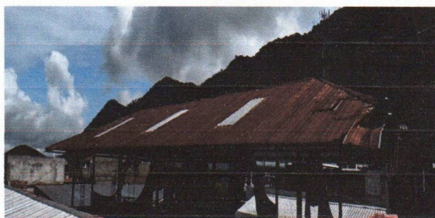
Foto 6: Sustrucion de lamina.
