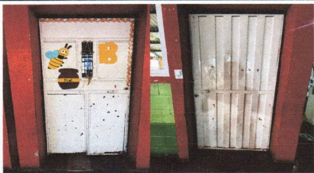
Foto 3: Sustrucción de puertas
