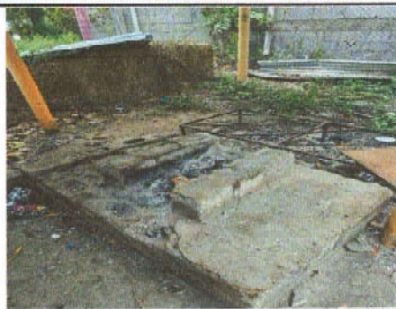
Foto 2: Reparación de estufa de leña en malas condiciones
