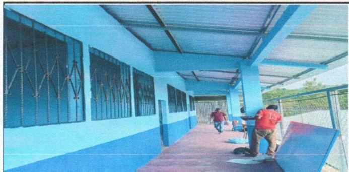
Foto 6: cambio de pintura en paredes interiores y exteriores
