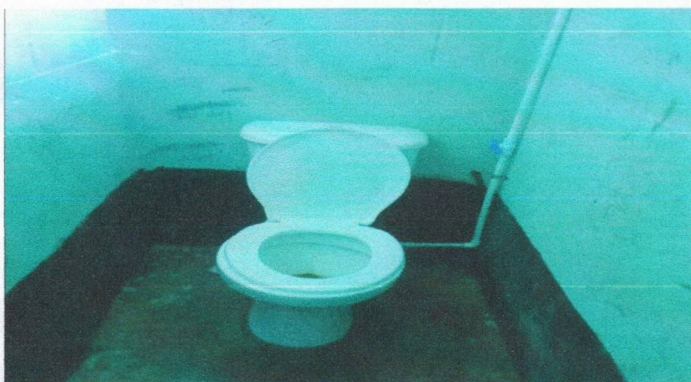
Foto 3: sustitución de tazas de sanitarios
