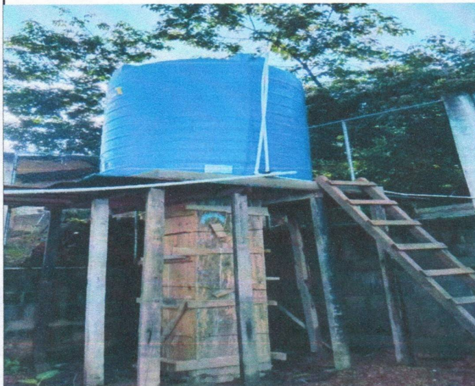
Foto1: sustitución de tinaco
