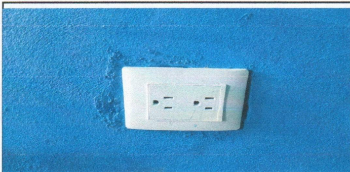
Foto 5: mejoramiento de tomacorrientes
