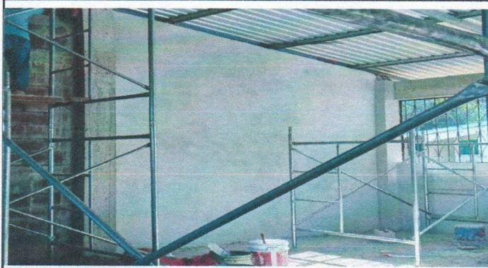
Foto 1: Repello de paredes de block
