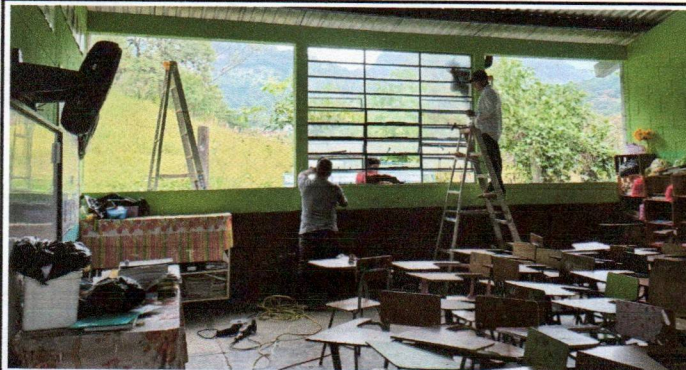
Foto1: Cambio de ventana de metal a pvc para mejorar la ventilación de las aulas.
