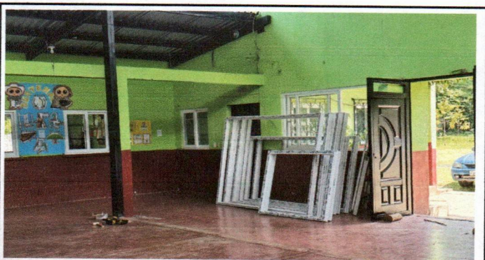
Foto 5: Cambio de ventana de metal a pvc por deterioro y para seguridad de la escuela.
