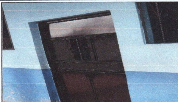
Foto 2: sustitucion de puerta de metal ( 2x1 metros)
