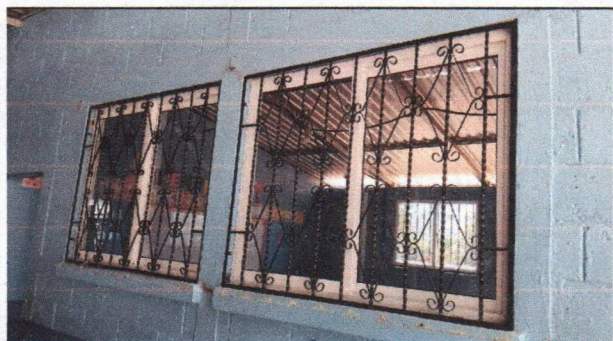
Foto 3: sustitucion de ventanas de pvc ( 1.50x1.26 metros)
