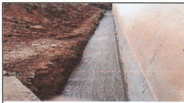
Foto 6: reparacion de cuneta de concreto
