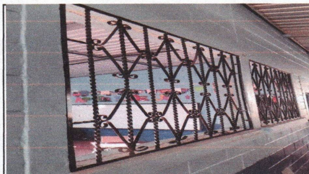
Foto 3: mantenimiento de balcones (lijado, pintado y colocacion)
