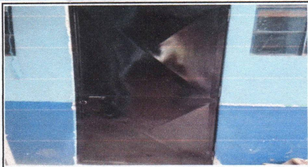
Foto 1: mantenimiento de puertas (chapa, pintura y colocacion)
