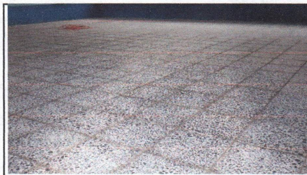
Foto 4: colocación de piso de granito
