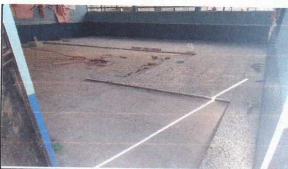
Foto 4: colocación de piso de granito
