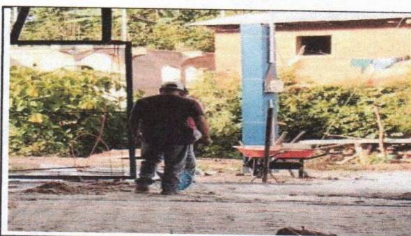
Foto 6: reparacion de cuneta de concreto
