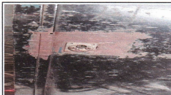
Foto 4: sustitucion de chapa
