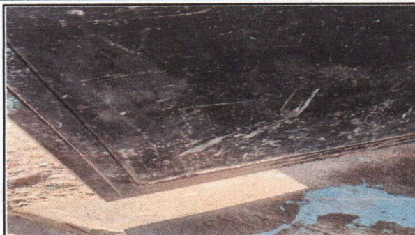
Foto 2: sustitucion de puerta de metal ( 2x1 metros)
