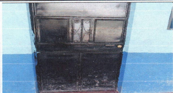
Foto 1: mantenimiento de puertas (chapa, pintura y colocacion)
