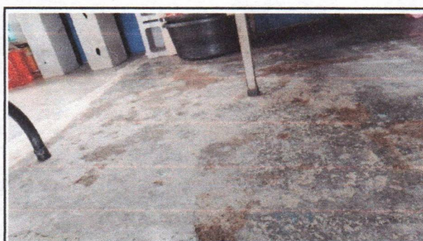
Foto 4: colocación de piso de granito
