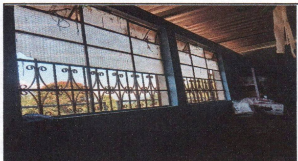
Foto 3: sustitucion de ventanas de pvc ( 1.50x1.26 metros)
