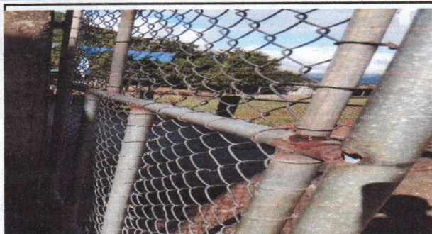
Foto1: sustitucion de porton (2.20x2.90)
