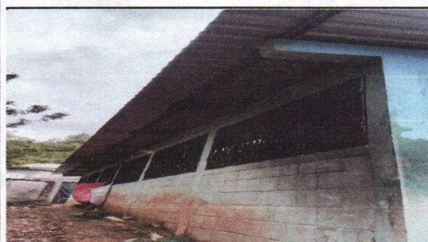
Foto 3: mantenimiento de balcones (lijado, pintado y colocacion)
