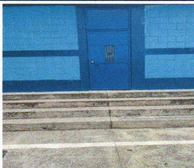
Foto 3: sustitucion de puerta
