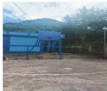
Foto 2: Mantenimiento a barandas de metal
