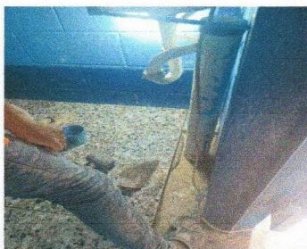
Foto 3: sustitucion de inodoro
