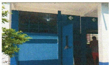
Foto 1: (Aplicación de pintura a puertas )
