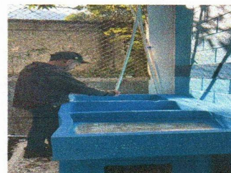
Foto 4: Sustitución de tubería línea principal para agua potable.
