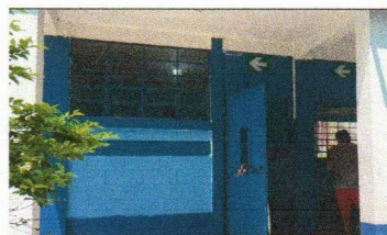
Foto 2; Sustitución de chapa
