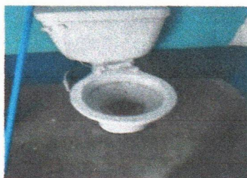
Foto 3: Sustitución de inodoro
