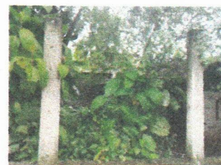
Foto 6: Sustitución de maya galvanizada
