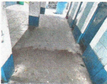
Foto 5.: Sustitución de piso de granito
