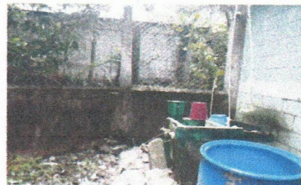
Foto 6: Sustitución de pila con dos lavaderos.
