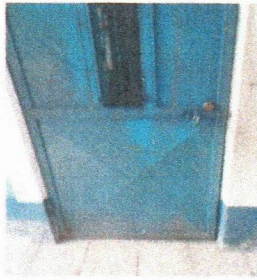
Foto 1: (aplicación de pintura)
