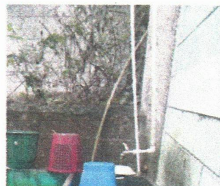
Foto 4: Sustitución de tubería línea principal para agua potable
