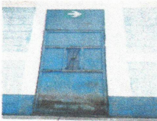
Foto 3: sustitución de puerta
