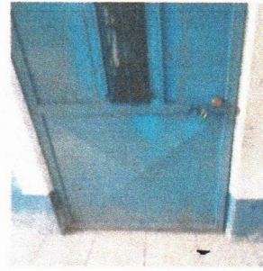
Foto 2: Sustitución de chapa
