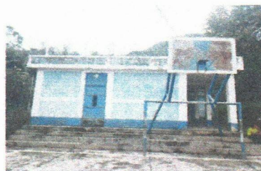
Foto 2: mantenimiento a barandas de metal
