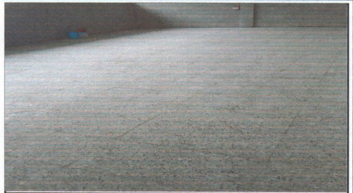
Foto 2: colocacion de piso de granito
