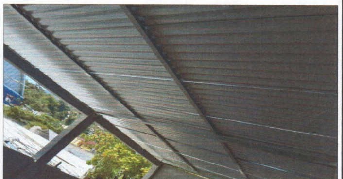
Foto 6: sustitucion de estructura de metal y lamina troquelada
