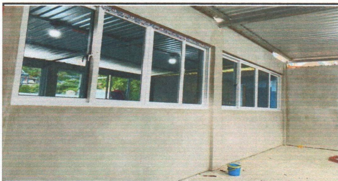
Foto 3: colocacion de ventanas
