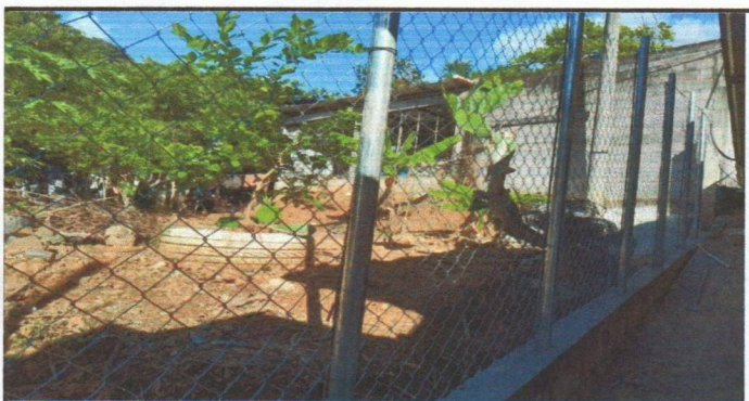
Foto 5: sustitucion de malla y soporte de metal
