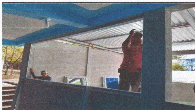
Foto 3: colocacion de ventanas
