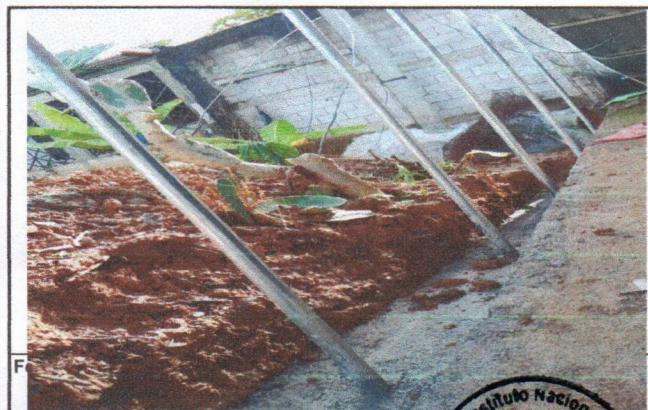
Foto 6: sustitucion de estructura de metal y lamina troquelada
