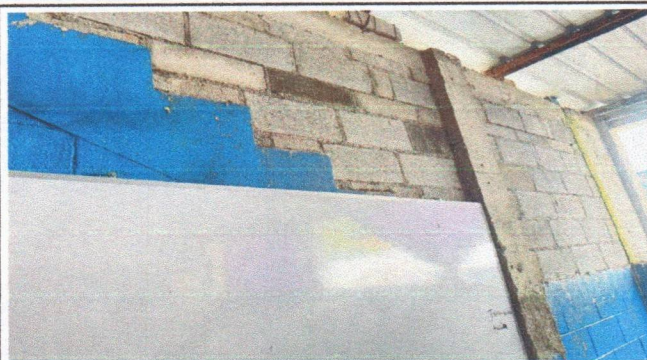
Foto 1: Repello de paredes de block
