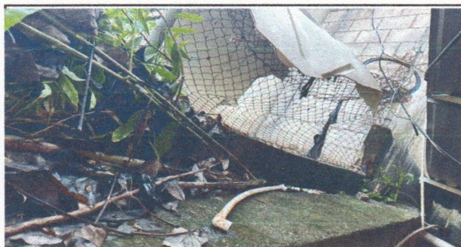
Foto 5: sustitucion de malla y soporte de metal
