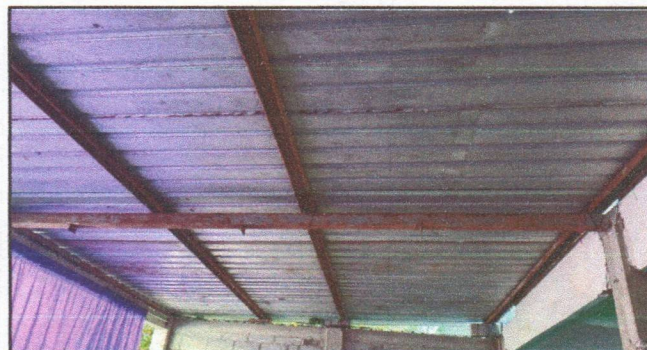
Foto 6: sustitucion de estructura de metal y lamina troquelada
