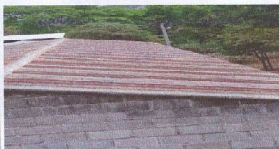
Foto 3 SUSTITUCION DEL TECHADO DE LAS LAMINAS
