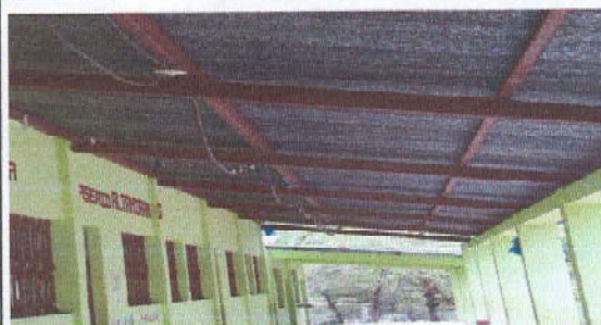
Foto 4: SUSTITUCION DEL TECHADO AMBOS LADOS
