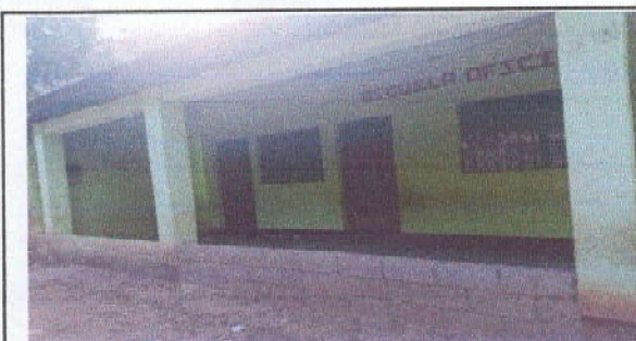
Foto 6: PINTURA EN MUROS EXTERIORES
