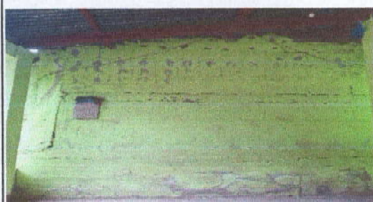
Foto 1 PINTURA EN INTERIORES Y EXTERIORES
