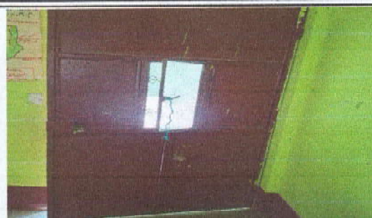
Foto 2: MANTENIMIENTOS DE PUERTAS
