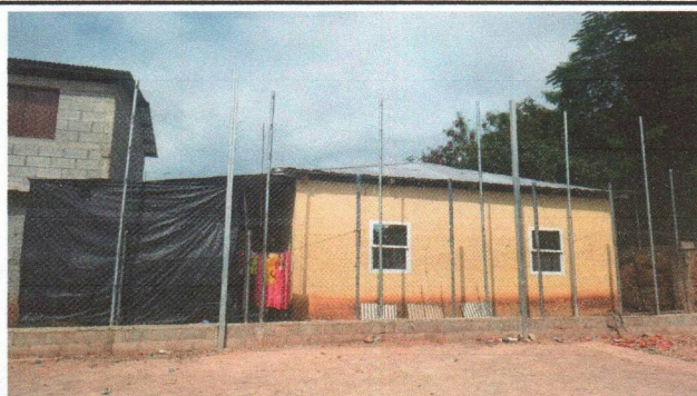
Foto 5: Reparación de tubo Hg y malla galvanizada.
