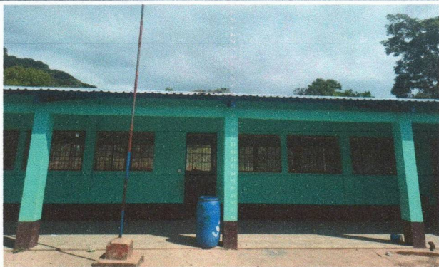
Foto1: Sustrucción de lamina, por lamina troquelada alzunic calibre 26
