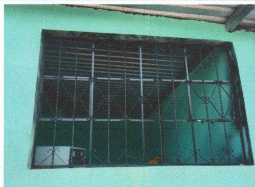
Foto 3: Sustrucción de vidrios
