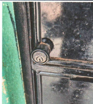
Foto 6: Sustrucción de chapa.
