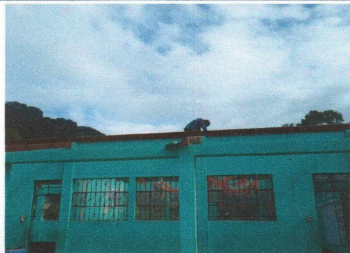
Foto1: Sustrucción de lamina, por lamina troquelada alzunic calibre 26
