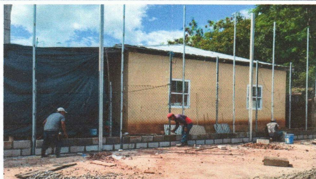
Foto 5: Reparación de tubo Hg y malla galvanizada.
