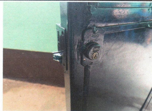
Foto 6: Sustitución de chapa
