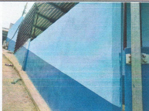
Foto 5: PINTURA DE MUROS Pintura en muros exteriores e interiores
