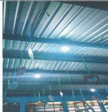
Foto 2: REPARACION DE SISTEMA ELÉCTRICO Reparación de Sistema Eléctrico:
