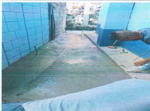
Foto 3: LOSA DE PATIO Reparación de planchas de concreto de patio
