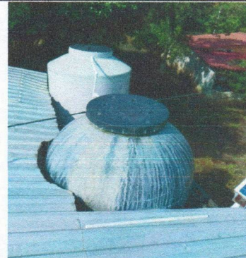
Foto 4: REPARACION Y MANTENIMIENTO DE CISTERNAS / DEPÓSITOS DE AGUA Sustitucion de accesorios deposito de agua
