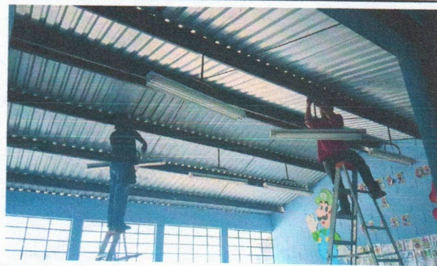
Foto 2: REPARACION DE SISTEMA ELÉCTRICO Reparación de Sistema Eléctrico:
