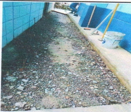
Foto 3: LOSA DE PATIO Reparación de planchas de concreto de patio
