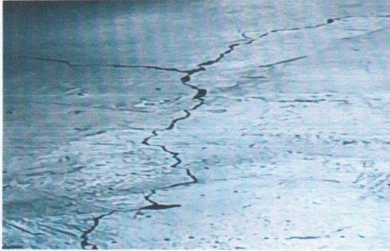
Foto 7: PISO Sustitución de piso de torta de concreto
