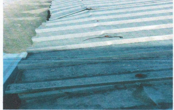
Foto 8: CUBIERTA DE LAMINA Sustitución de lámina, por lámina troquelada aluzinc calibre 26
