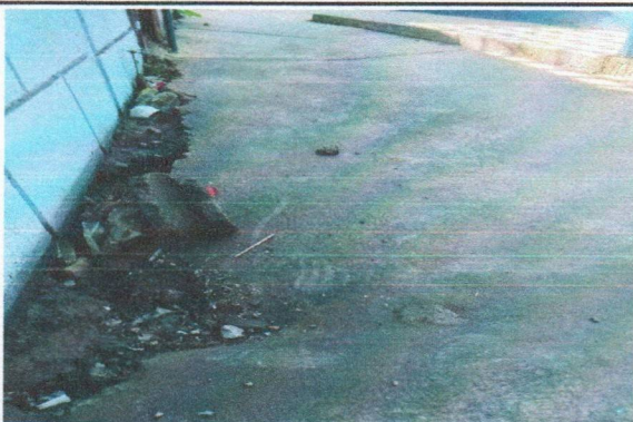
Foto 3: LOSA DE PATIO Reparación de planchas de concreto de patio
