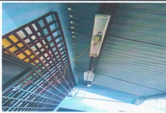
Foto 2: REPARACION DE SISTEMA ELÉCTRICO Reparación de Sistema Eléctrico:
