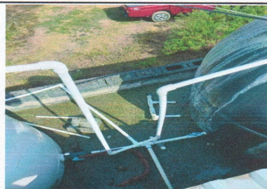
Foto 4: REPARACION Y MANTENIMIENTO DE CISTERNAS / DEPÓSITOS DE AGUA Sustitución de accesorios depósito de agua
