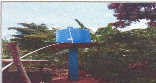
Foto 5: SUSTITUCIÓN DE TINACO
