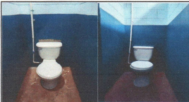
Foto1: SUSTITUCIÓN DE INODOROS
