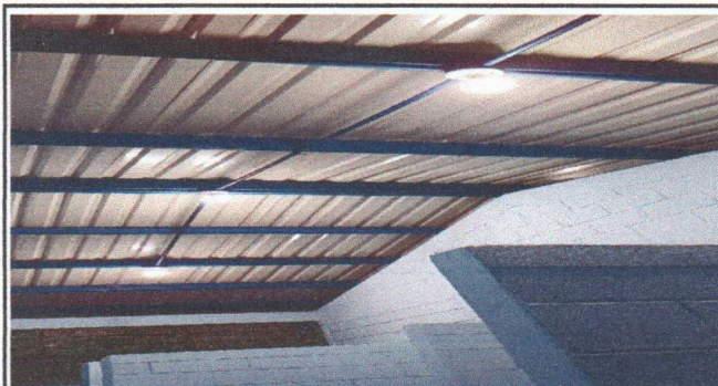
Foto 3: REPARACIÓN DEL SISTEMA ELÉCTRICO
