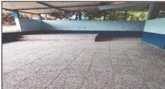
Foto 2: SUSTITUCIÓN DE PISO DE CONCRETO
