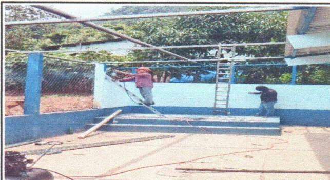
Foto 4: SUSTITUCIÓN DE LÁMINA
