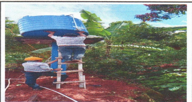
Foto 5: SUSTITUCIÓN DE TINACO
