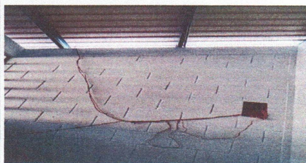
Foto 3: REPARACIÓN DEL SISTEMA ELÉCTRICO
