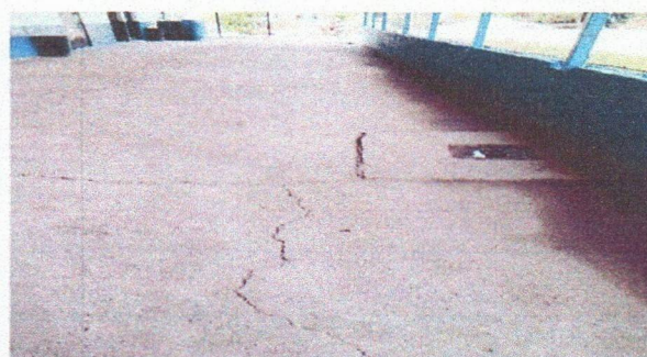
Foto 2: SUSTITUCIÓN DE PISO DE CONCRETO
