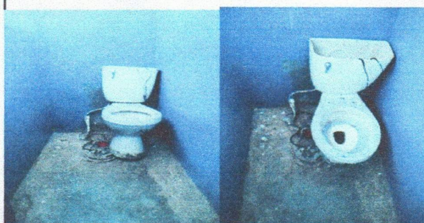
Foto1: SUSTITUCIÓN DE INODOROS
