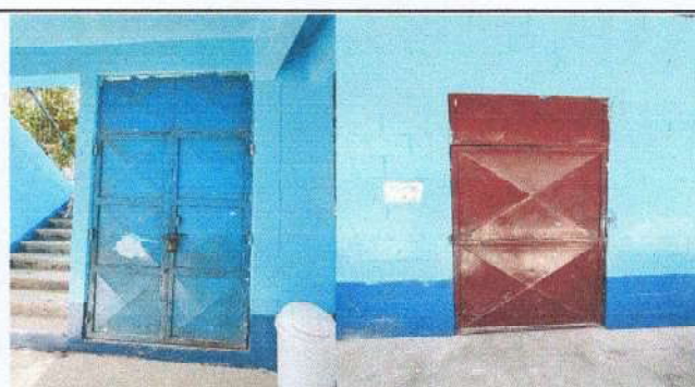
Foto 12: SUSTITUCION DE CHAPAS EN PUERTAS
