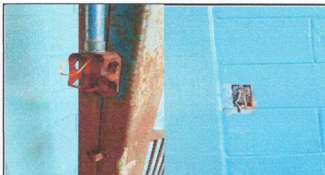
Foto 10: SUSTITUCION DE TOMACORRIENTES E INTERRUPTORES
