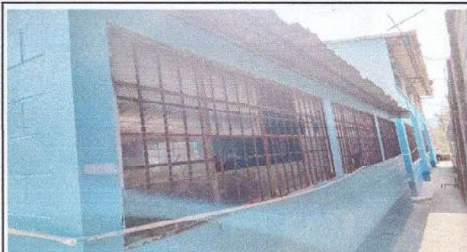
Foto13: SUSTITUCIÓN DE ESTRUCTURAS DE VENTANAS
