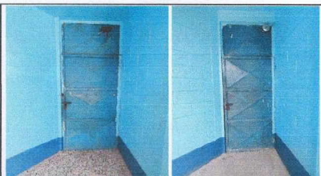
Foto 11: MANTENIMIENTO A ESTRUCTURAS DE PUERTAS
