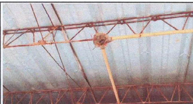
Foto 9: SUSTITUCION DE PLAFONERAS
