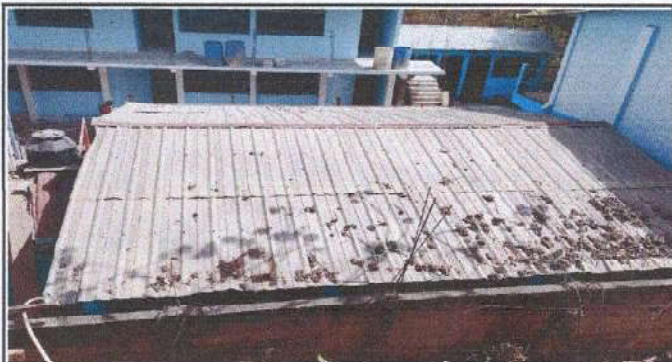
Foto 1: SUSTITUCIÓN DE LAMINA POR LAMINA TROQUELADA CALIBRE 26
