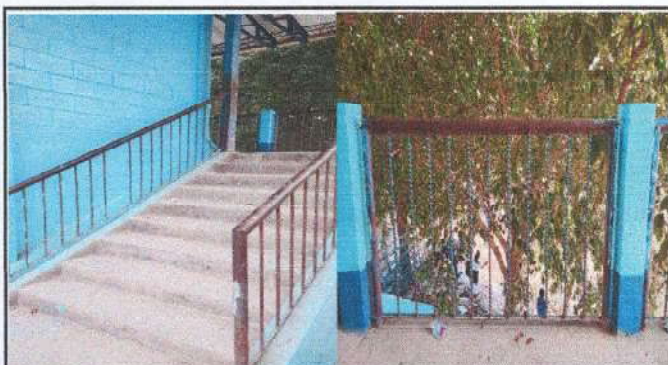
Foto 15: MANTENIMIENTO DE VARANDAS DE METAL
