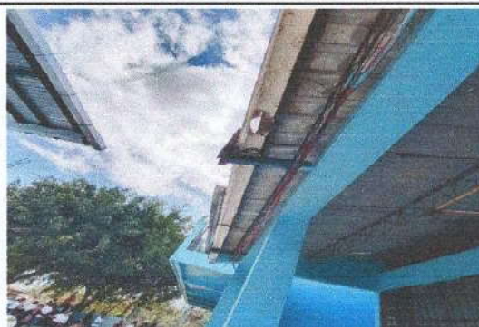
Foto 14: SUSTITUCIÓN DE CANALES DE PVC
