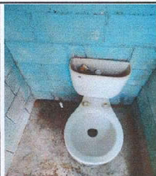
Foto 3: SUSTITUCIÓN DE INODOROS
