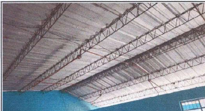
Foto 2: SUSTITUCIÓN DE ESTRUCTURA DE METAL POR METAL
