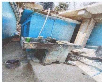
Foto 4: SUSTITUCIÓN DE PILA DE CONCRETO
