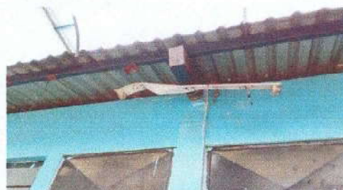
Foto 8: SUSTITUCIÓN DE LAMPARAS LED
