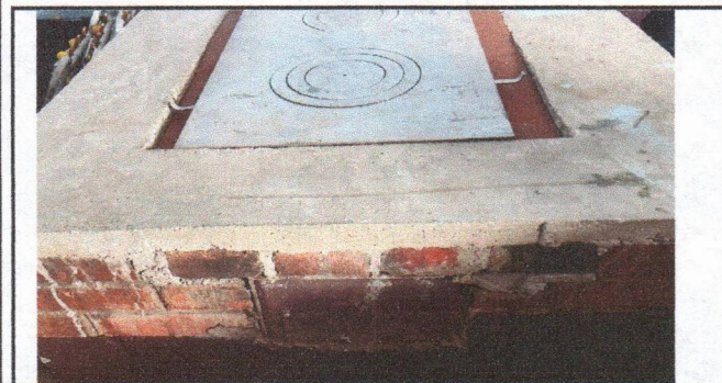
Foto 5: Sustitucion de plancha de tres hornillas de cocina
