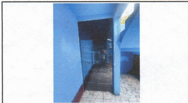
Foto 2: Sustitucion de puertas de 2.55 por 1 mts.
