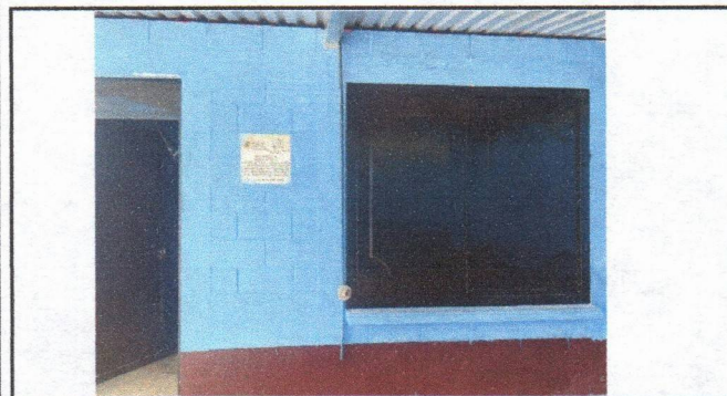
Foto 3: Sustición de estructura de metal de ventana de cocina de 2mts. Por 1.75 mts.
