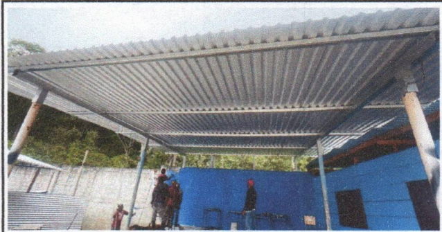
Foto 2: Sustitucion de metal por metal
