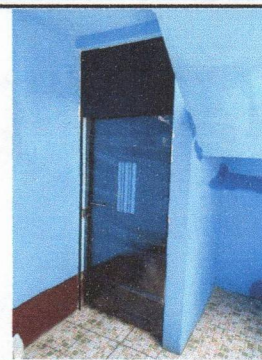
Foto 2: Sustitución de puertas de 2.55 por 1 mts.
