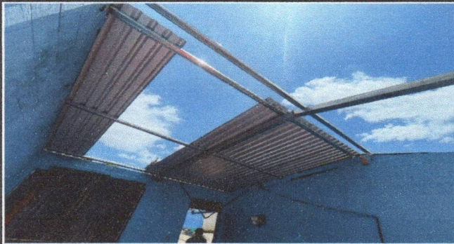
Foto 1: Sustrucion de lamina, por lamina troquelada calibre 26
