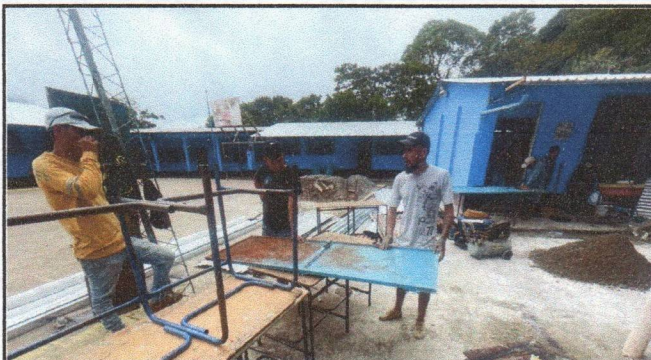
Foto 1: Mantenimiento de estructura (lijado y aplicación de pintura a puertas)
