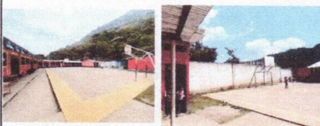
Foto 6: Pintura de muros interiores y exteriores
