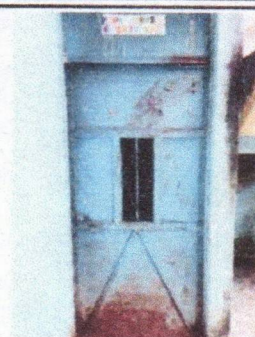
Foto 2: Sustitución de puertas de 2.55 por 1 mts.
