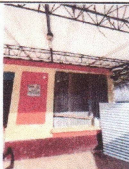
Foto 3: Sustitución de estructura de metal de ventana de cocina de 2 mts. Por 1.75 mts.
