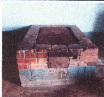
Foto 5: Sustitución de plancha de tres hornillas de cocina
