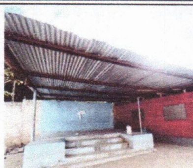
Foto 2: Sustitución de soporte de metal por metal
