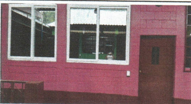
Foto 3: Sustitución de puerta en al dirección
