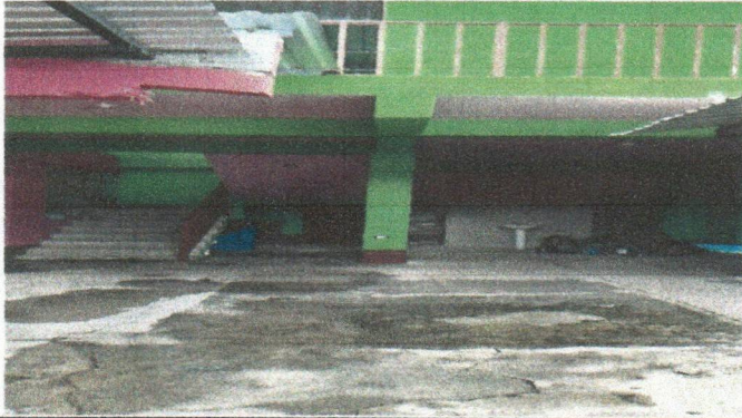
Foto 1: Mejoramamiento de repello de terraza y columnas
