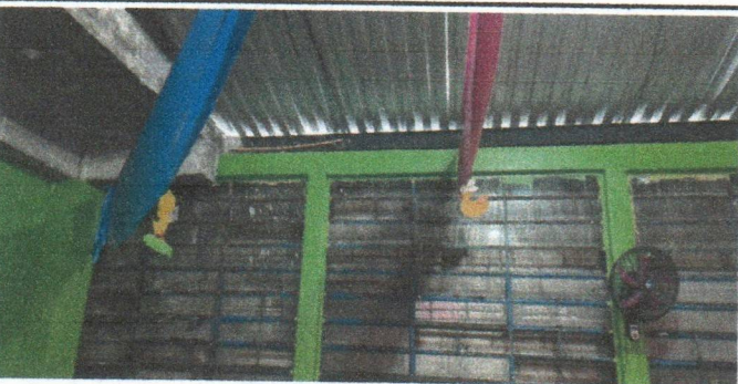
Foto 5: Mejoramiento de canal en una aula
