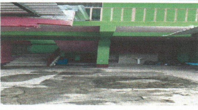
Foto 3: Mejoramineto de barandas
