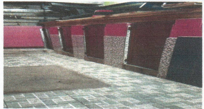
Foto 2: Mejpramiento de puertas de baños
