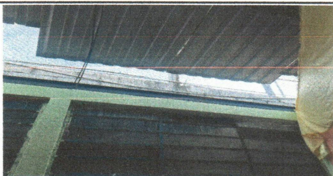
Foto 5: Mejoramiento de canal en una aula
