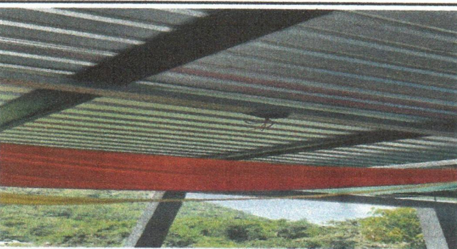
Foto 5: Instalación eléctrica de aulas
