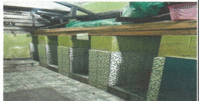
Foto 2: Mejpramiento de puertas de baños
