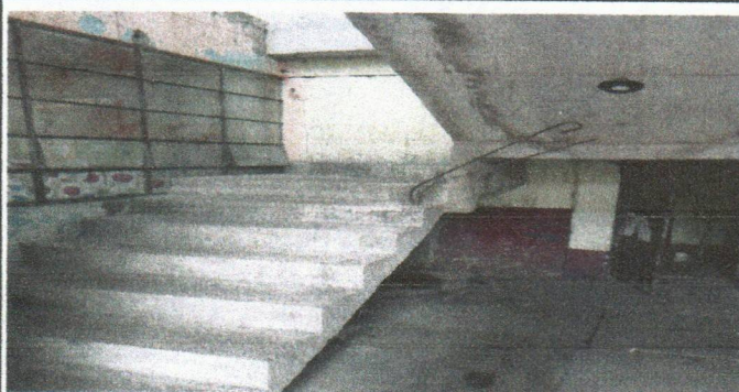
Foto 3: Mejoramiento de barandas
