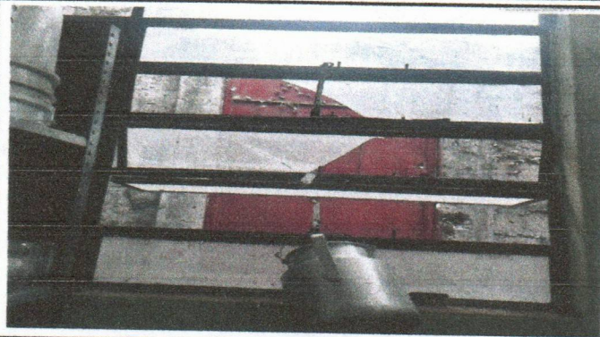
Foto1: Sustitución de vidrios
