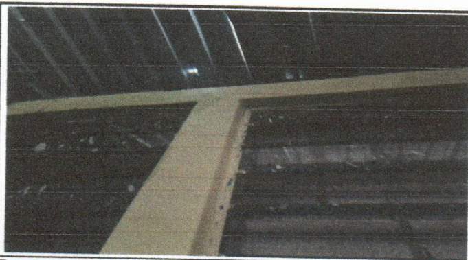
Foto 5: Mejoramiento de canal en una aula
