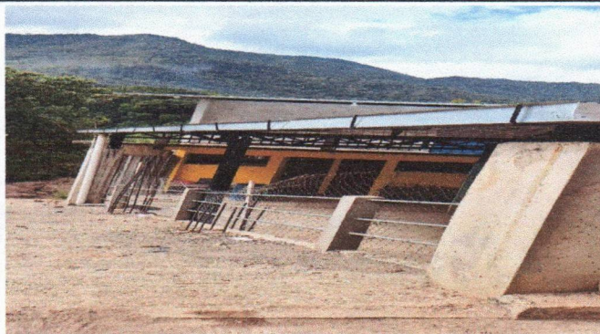
Foto1: SUSTITUCION DE CANALES DE PVC POR METAL
