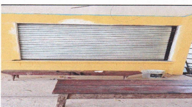
Foto 4: SUSTITUCIÓN DE VENTANA DE METAL
