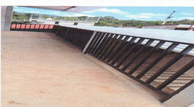
Foto 6: SUSTITUCION DE BARANDAS
