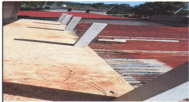
Foto 6: SUSTITUCIÓN DE BARANDAS
