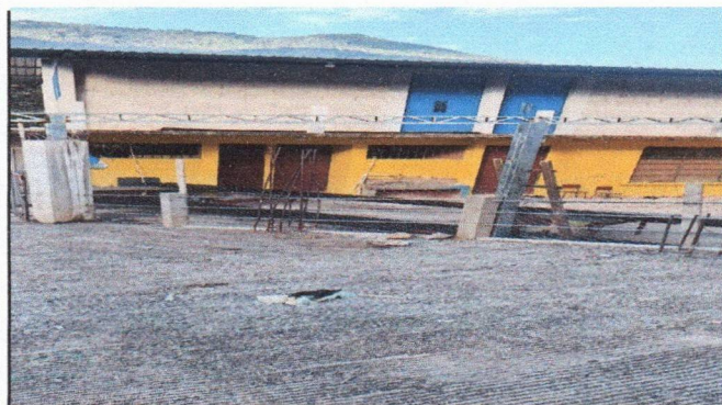
Foto 3: SUSTICIÓN DE LAMINA POR LAMINA TROQUELADA ALOZINC
