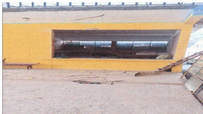
Foto 4: SUSTITUCIÓN DE VENTANA DE METAL
