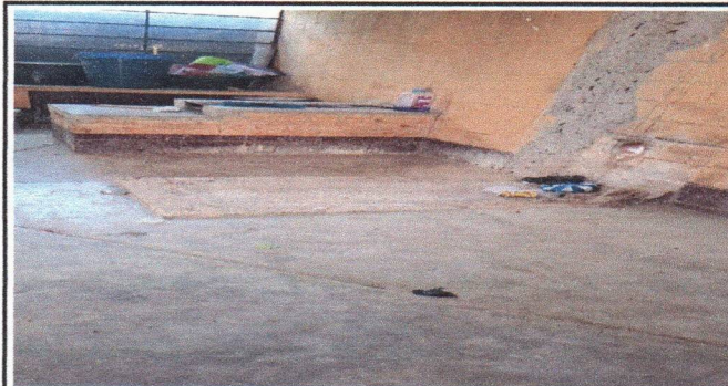
Foto 2: REPARACION Y MANTENIMIENTO DE ESTUFA O FOGON
