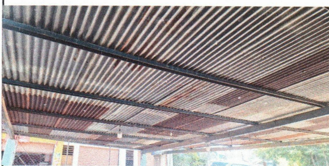
Foto 5: SUSTITUCION DE LAMINA POR LAMINA TROQUELADA ALUZINC
