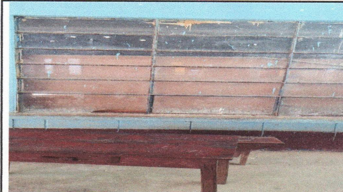
Foto 4: SUSTITUCION DE VENTANA DE METAL
