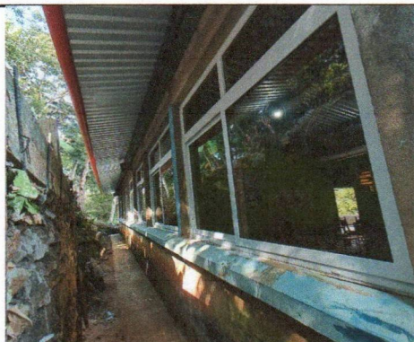
Foto 3: Sustitución de ventanas de metal por material PVC mas vidrio, 24 mts. cuadrados.
