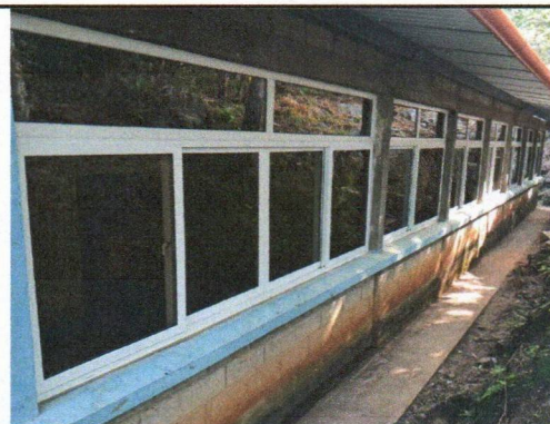
Foto 4: Sustitución de ventanas de metal por material PVC mas vidrio, 24 mts. cuadrados.
