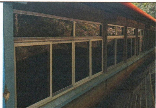
Foto 4: Sustitución de ventanas de metal por material PVC mas vidrio, 24 mts. cuadrados.
