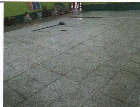
Foto 6: Sustitución de piso de granito, 145 mts. Cuadrados
