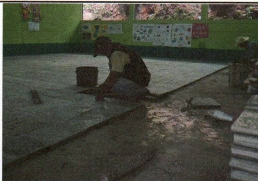
Foto 5: Sustitución de piso de granito, 145 mts. cuadrados
