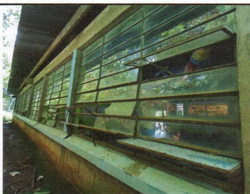
Foto 3: Sustrución de ventanas de metal por material PVC mas vidrio, 24 mts. cuadrados.
