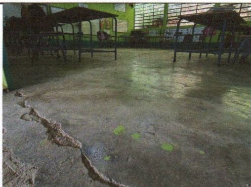
Foto 5: Sustrución de piso de granito, 145 mts. cuadrados
