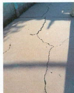
Foto 4: Reparación de plancha de concreto de patio.
