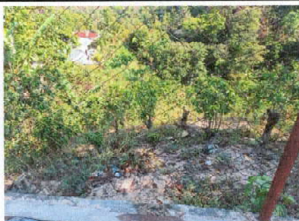
Foto 3: Sustrucción de malla galvanizada
