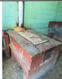
Foto 2: Sustrucción de plancha metal de cocina de 3 ornillas
