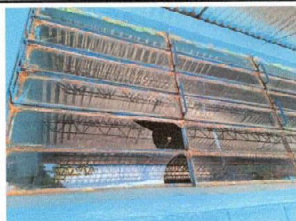
Foto 6: Sustrucción de vidrios de ventanas
