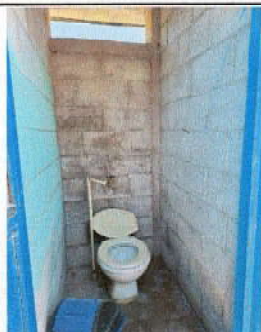
Foto 1: Sustrucción de inodoros
