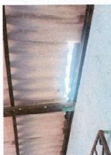
Foto 5: Sustrucción de lamina por lamina troquelada aluzinc calibre 26
