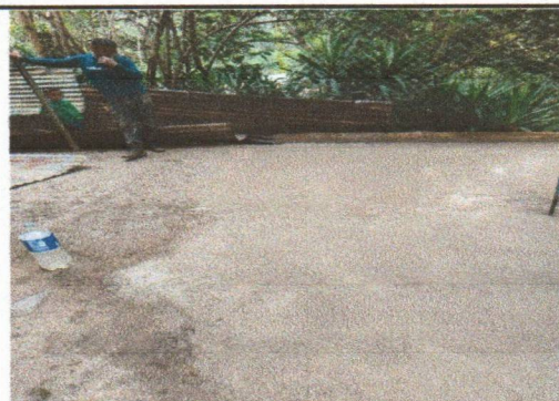
Foto 4: Piso de concreto en buen estado.
