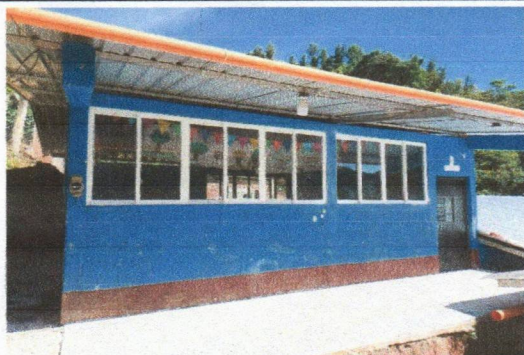
Foto 5: Ventanas con estructura de metal-aluminio en buen estado
