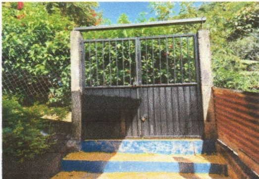
Foto 1: Porton de ingreso en buen estado.
