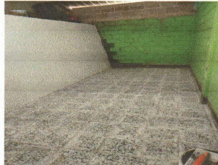
Foto 2: Instalacion y colocacion de piso de granito por piso de concreto dereriorado
