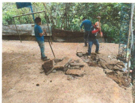
Foto 4: Demolicion de piso deteriorado para sustituirlo nuevamente
