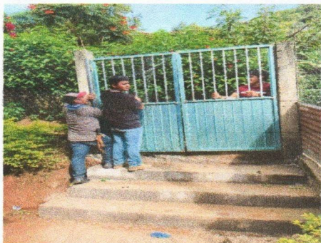
Foto1: Sustitucion de porton de metal +malla por porton de metal
