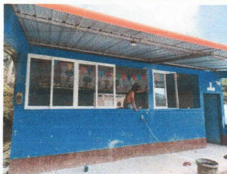
Foto 5: Instalacion de ventanas con estructura de metal + aluminio.
