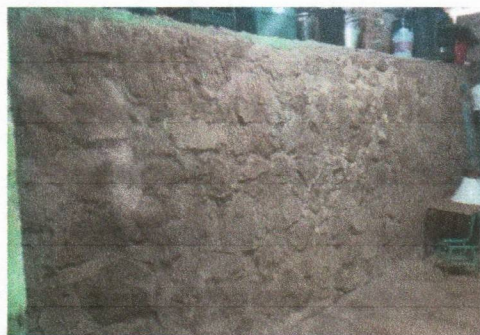
Foto 3: Área de colocación de repello.
