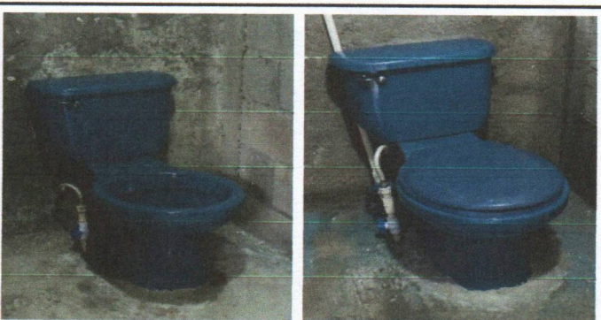
Foto 6: NUEVOS INODOROS YA INSTALADOS.
