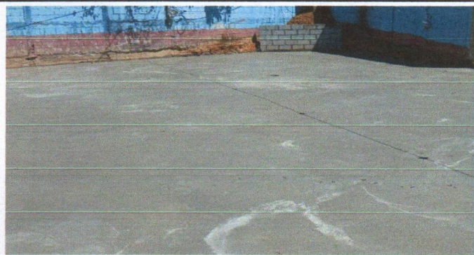
Foto1: LA NUEVA LOSA YA FUNDIDA.
