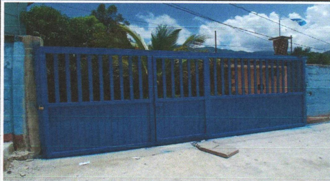
Foto 4: NUEVO PORTÓN DE LA ENTRADA PRINCIPAL YA INSTALADO.
