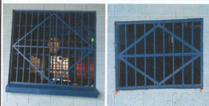
Foto 3: NUEVAS VENTANAS EN AULAS Y COCINA YA INSTALADAS.
