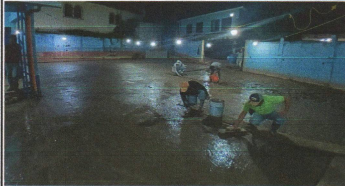
Foto 2: PROCESO DE LEVANTADO DE LA LOSA EN MAL ESTADO.
