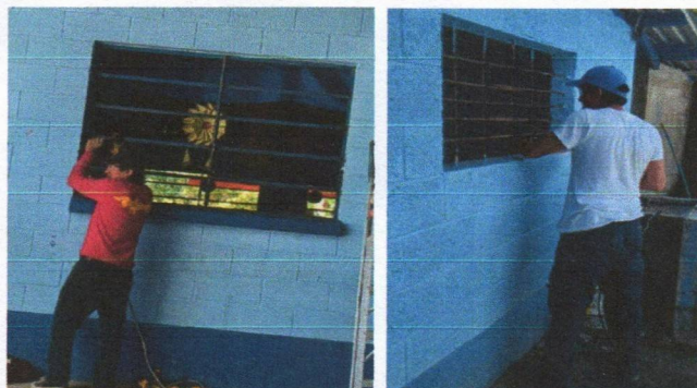
Foto 3: INSTALACIÓN DE LAS NUEVAS VENTANAS EN AULAS Y COCINA.
