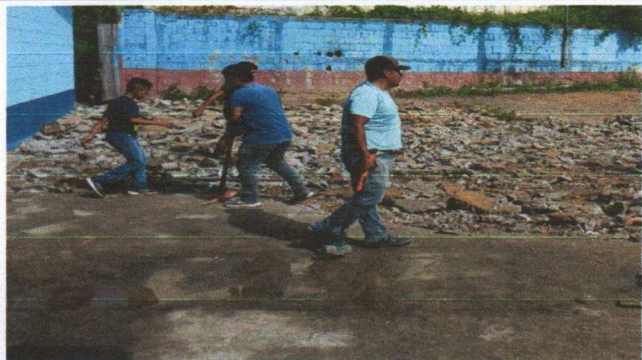
Foto1: PROCESO DE LEVANTADO DE LA LOSA EN MAL ESTADO.
