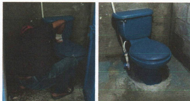
Foto 6: INSTALACIÓN DE LOS NUEVOS INODOROS.
