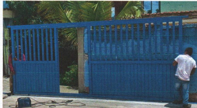
Foto 4: INSTALACIÓN DEL NUEVO PORTÓN DE LA ENTRADA PRINCIPAL.
