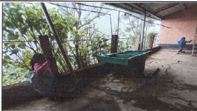
Foto 2: Reparación de muro perimetral
