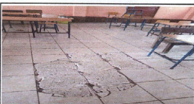
Foto 6: Sustrucción de piso por piso granito
