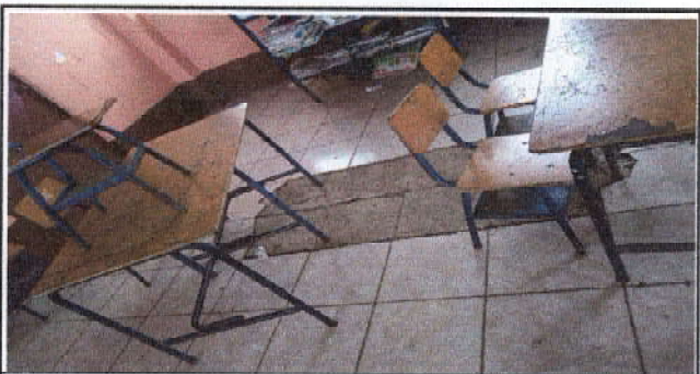
Foto 5: Sustrucción de piso por piso granito
