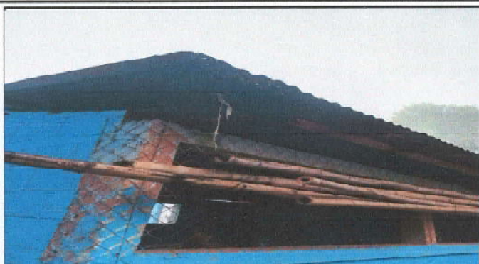
Foto 1: SUSTITUCION CUBIERTA DE LAMINA
