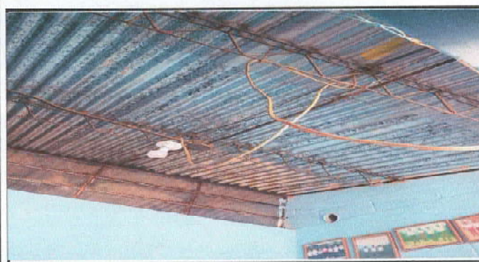
Foto 5: REPARACION DE SISTEMA ELECTRICO
