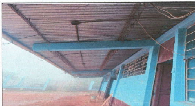
Foto 3: CAMBIO DE CANALES Y BAJADAS DE AGUA PLUVIAL
