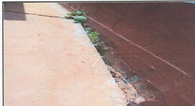
Foto 4: REPARACION DE LOSA DE PATIO
