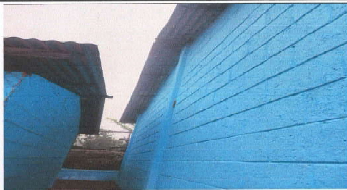
Foto 2: SUSTITUCION ESTRUCTURA DE TECHO
