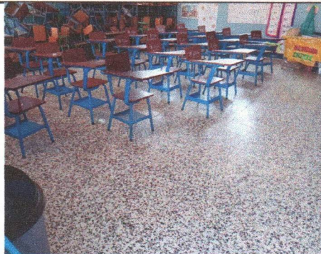
Foto 2: Sustrución de piso de concreto por piso tipo granito
