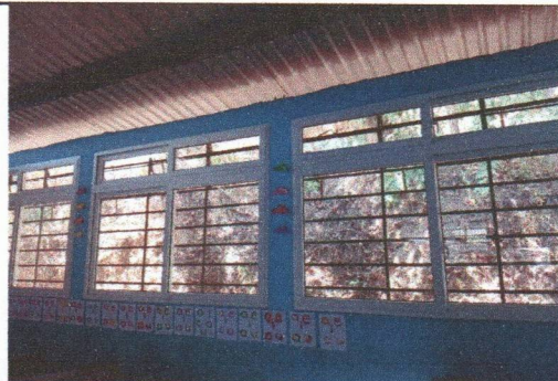
Foto 6: Sustrución de ventana de metal
