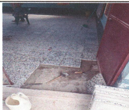
Foto 2: Sustrución de piso de concreto por piso tipo granito
