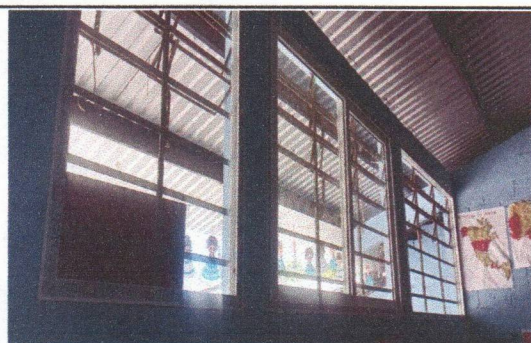
Foto 5: Sustrución de ventana de metal
